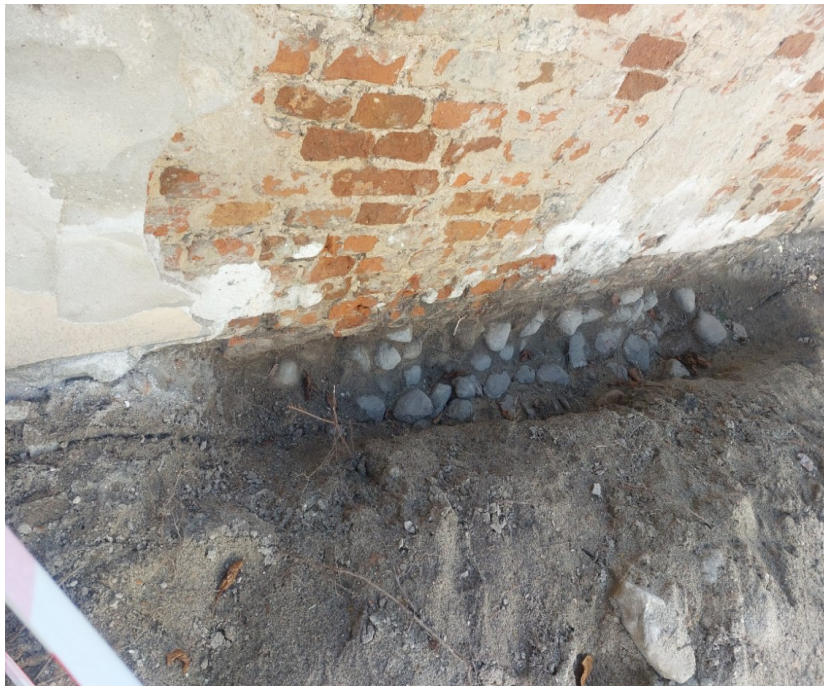
Fundament – otoczaki (luźne kamienie eratyczne) na głębokości 20 cm
