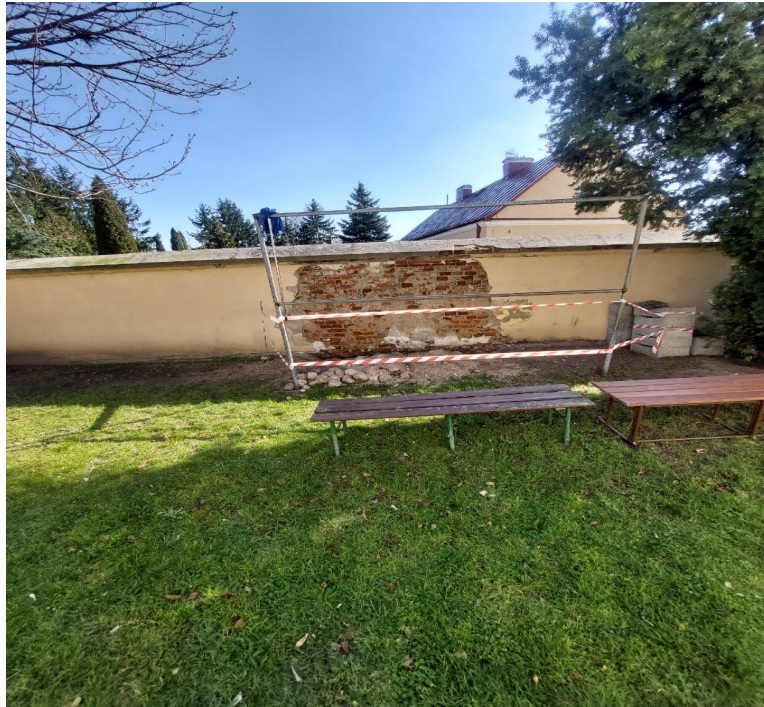
Widok skutego tynku fragmentu muru i daszku
