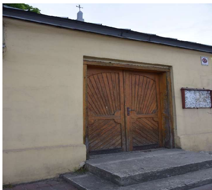
Schody do kapliczki północno-wschodniej betonowe - do demontażu i ponownego ułożenia z kamienia
