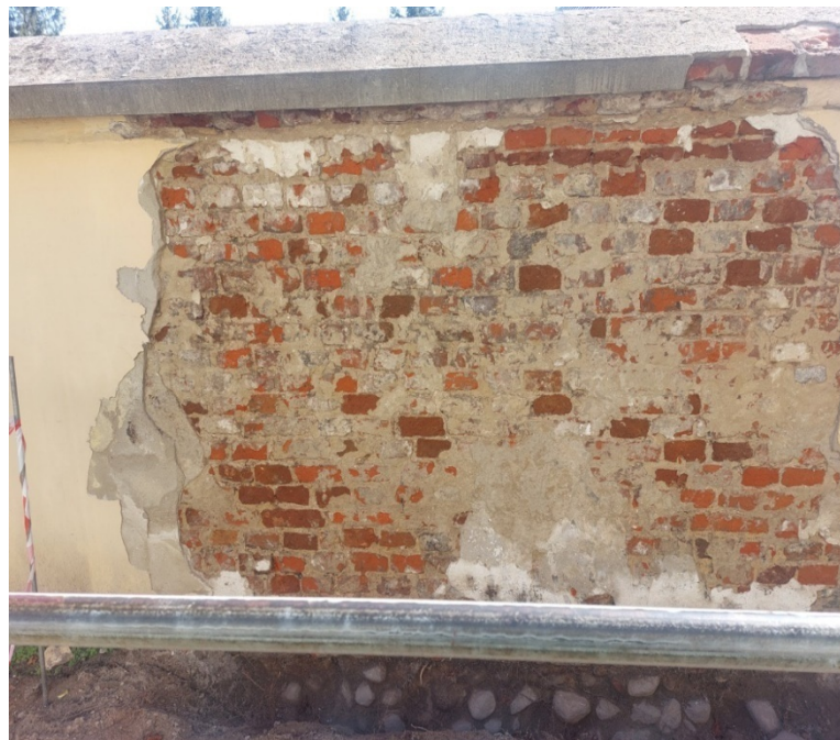
Mur z cegły i daszek z cegły ceramicznej pełnej
