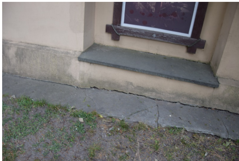
Opaska betonowa wzdłuż muru do demontażu
