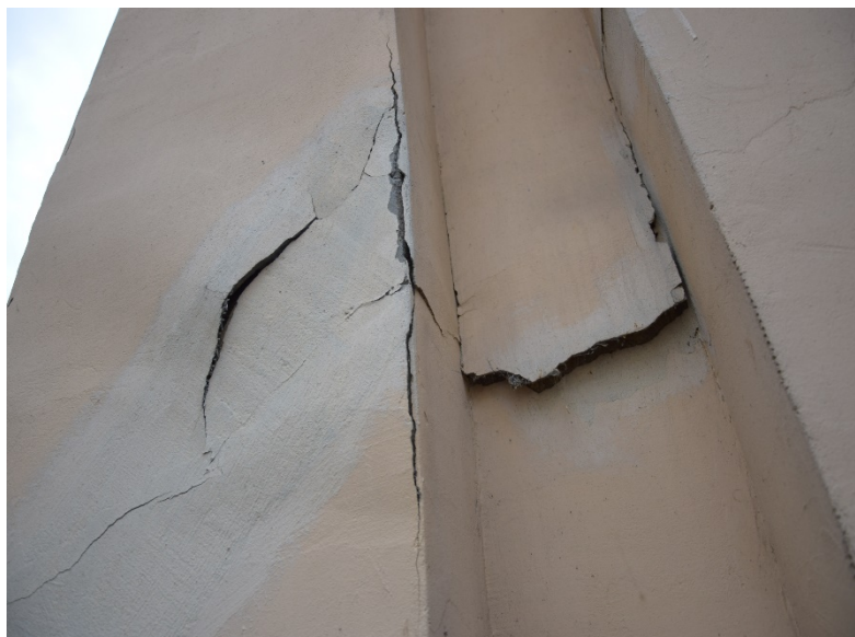
Odspojenia tynku na obramieniu bramy wejściowej
