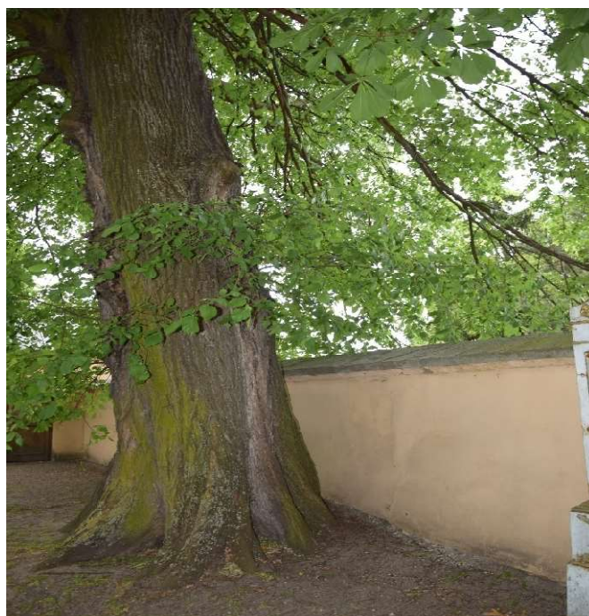
Drzewo uszkadzające mur wycięcie drzewa wg odrębnego opracowania
